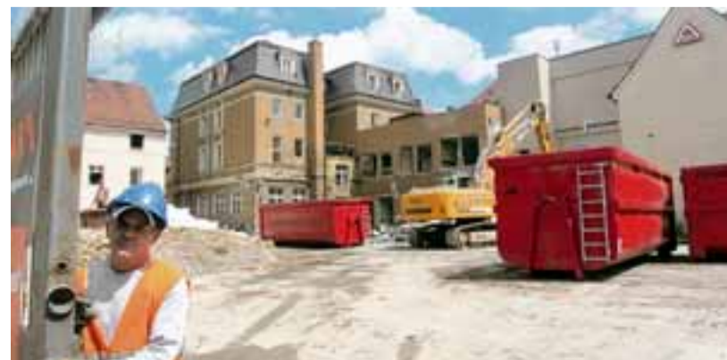
Auf dem Reiter-Gelände haben die Abbrucharbeiten begonnen. 2017 sollen hier rund 50 neue Wohnungen bezugsfertig sein.
